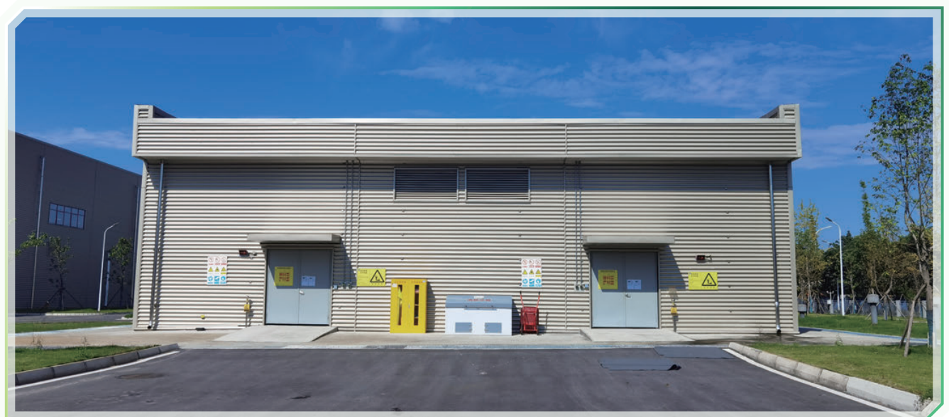
有害廢物貯存倉庫
